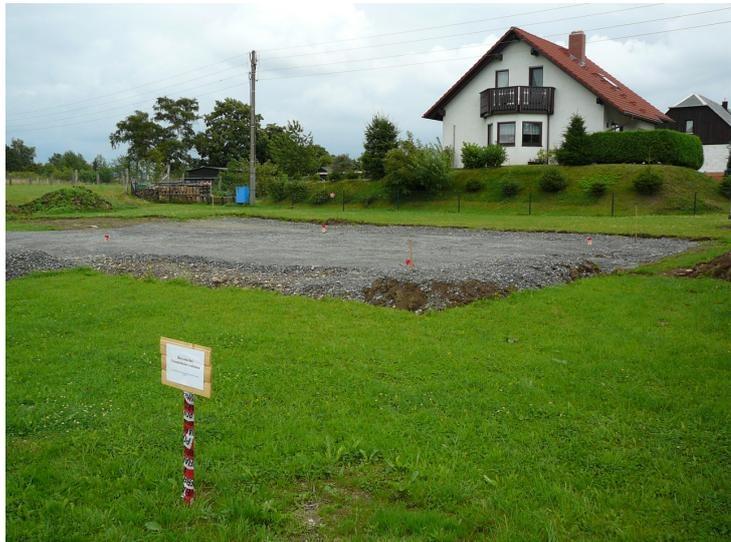
notwendig diese Grundstücksgrenzen vorher von einem Öffentlich bestellten Vermessungsingenieur wiederherstellen zu lassen. Dabei wird die Lage der Grenze exakt bestimmt. Erst dies ermöglicht einen sicheren Bezug des Baukörpers im Grundstück.
